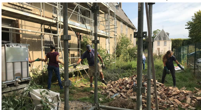
Chantiers de réemploi de la Manuf' à Vernon
